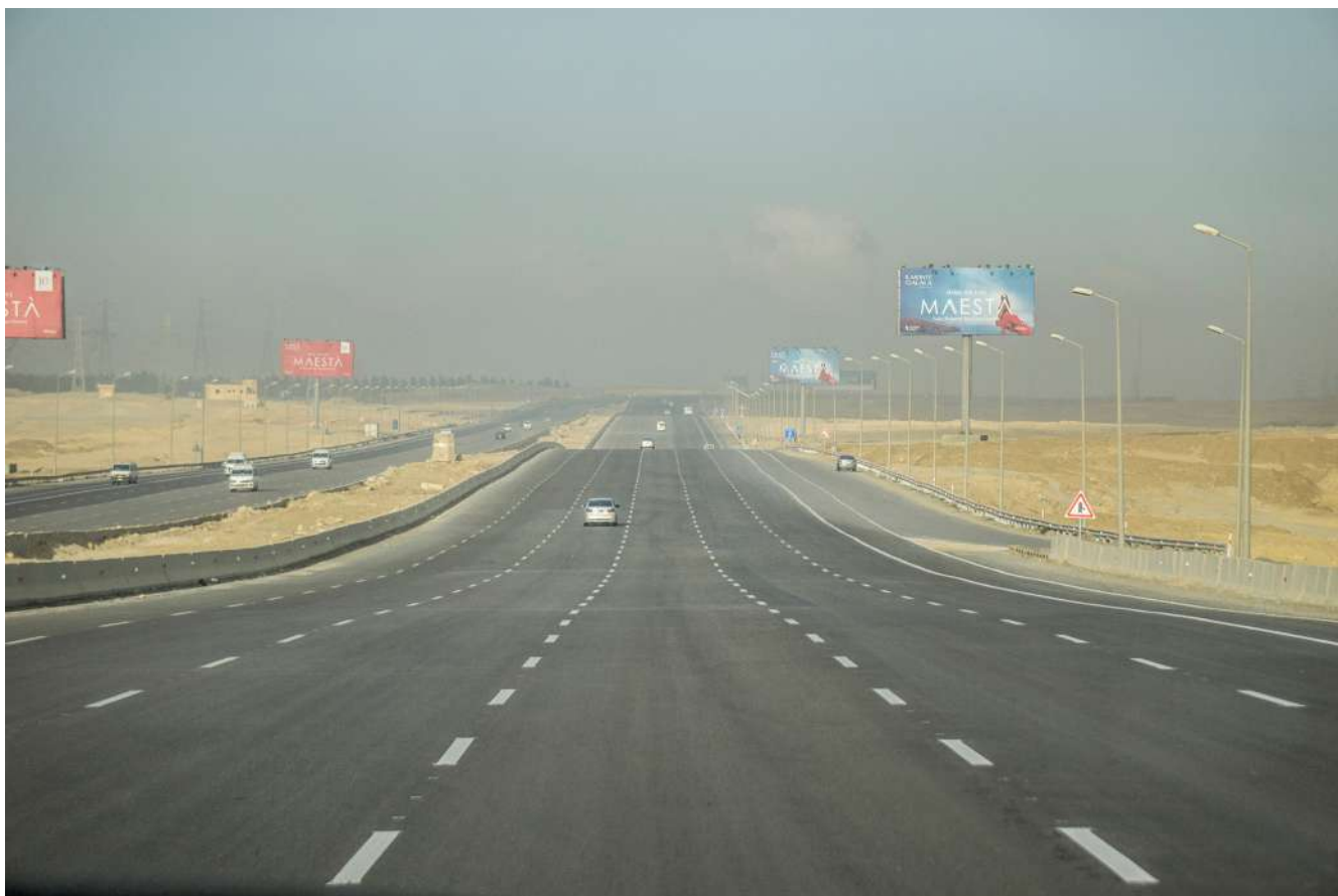
Autopista del nou projecte de ciutat egípcia New Capital, un projecte clarament insostenible i actualment en crisi de finançament. Font: Rafael López-Monné.
