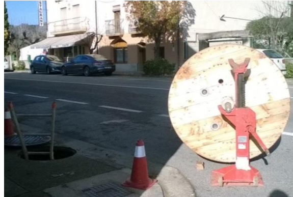
Instal·lació de cablejat
